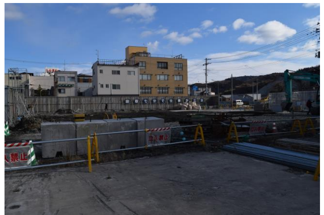
橋通り側(南側)より撮影(2月15日)
