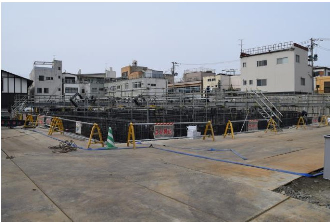
基礎配筋工事が進められている現場(撮影:3月6日)
