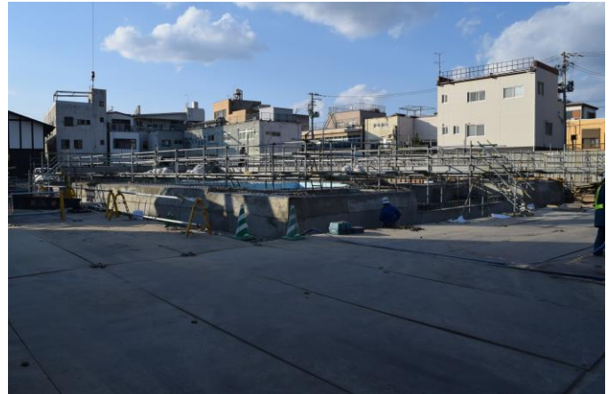
コンクリートの基礎部分が見えてきた現場(撮影:3月17日)
