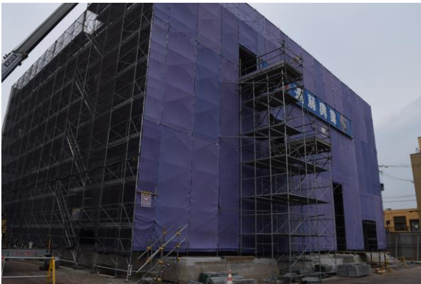
建物全体に足場が組み立てられた現場(撮影:6月7日)
