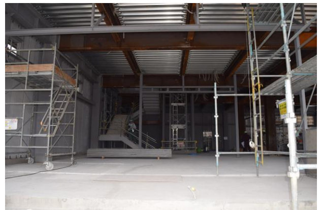
1階内部も階段などが組み立てられてきた(撮影:6月7日)
