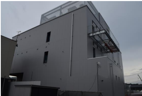
屋上に各種設備も設置されました(建物北側)
