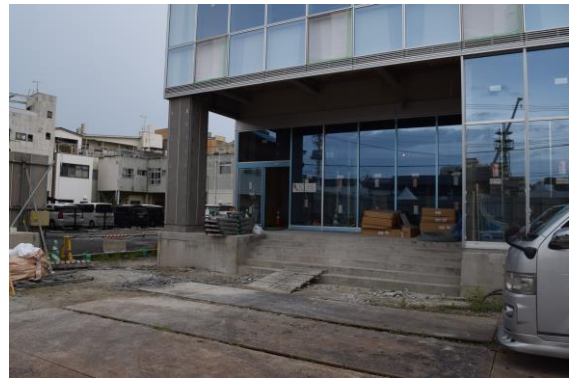
橋通り側(南側)入口
